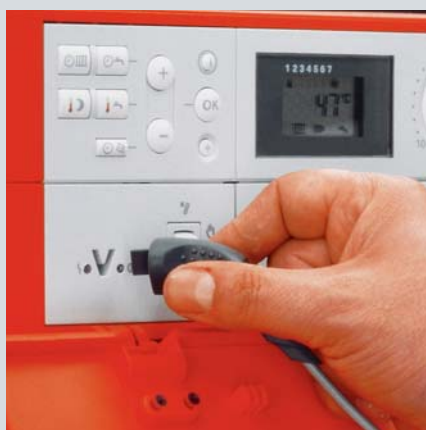
Rychlé připojení pomocí osvědčeného rozhraní laptopu Optolink
