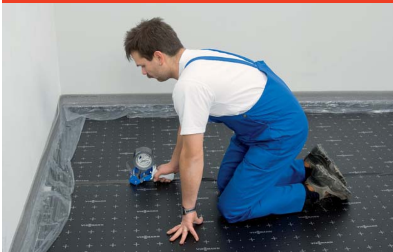
Obr. 16: Překrytí lepicí páskou
