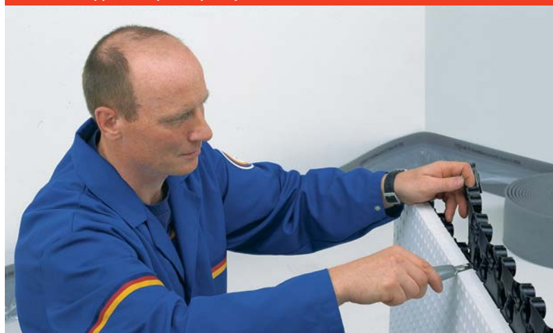
Obr. 3: Fóliový přesah nopového prvku je nutné odřeznout
