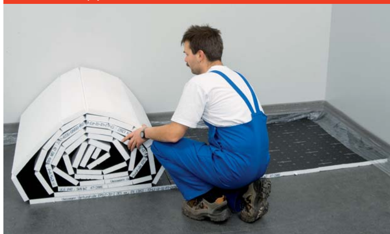
Obr. 15: Pokládka spojovacího materiálu
