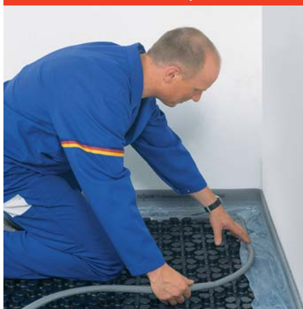
Obr. 8: Pokládka kruhového PE-profilu
