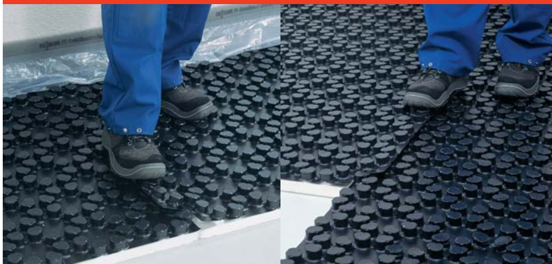
Obr. 7: Spojování přesahů nopových desek
