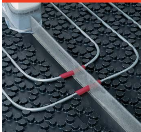
Obr. 11: Pokládka vyrovnávacího nopového prvku
