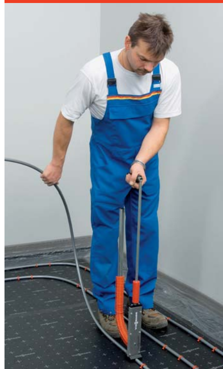
Obr. 17: Kotvicí sponky trubky těsně obepnou
