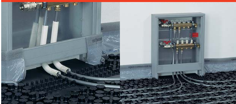
Obr. 12: Pokládka vodících oblouků
