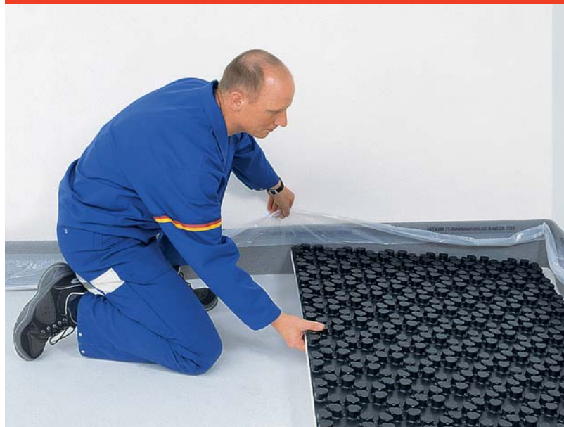
Obr. 4: Pokládka nopového prvku
