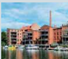
Ateliérové byty Brandenburg, Německo
