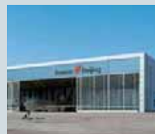
Ameco A380 Hangar Peking, Čína
