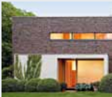
Einfamilienhaus Kevelaer, Deutschland
