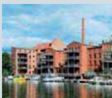
Ateliérové byty Brandenburg, Německo
