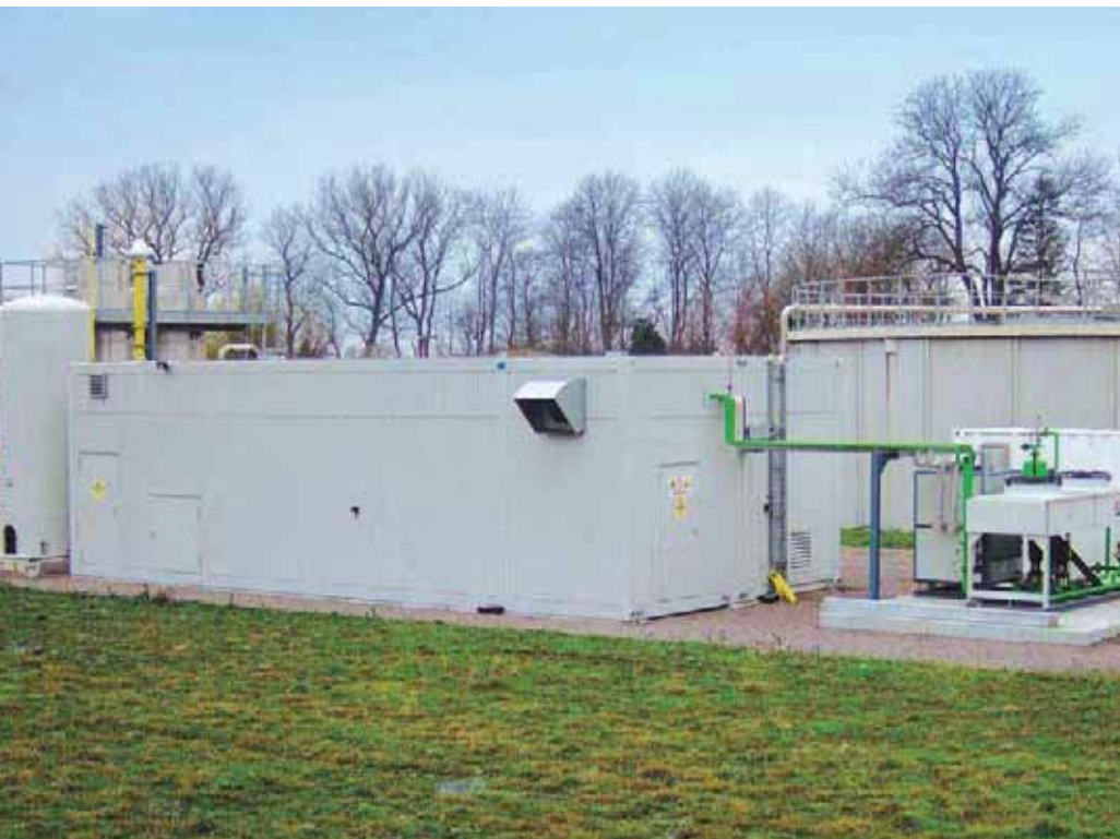
Ve městě Wrams se potravinový a jatečný odpad upravuje na vysoce kvalitní bio zemní plyn
