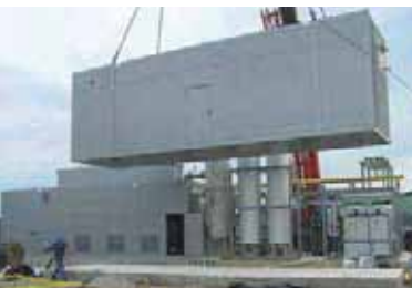
Jednoduchá manipulace na staveniš- ti díky kontejnerovému provedení, které je připraveno k provozu
