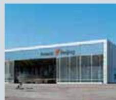
Ameco A380 hangar Peking, Čína
