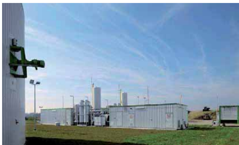
Úpravna pro bio zemní plyn s úsporou místa díky instalaci do standardních kontejnerů
