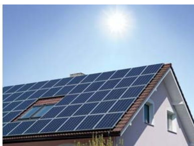
Fotovoltaické panely Vitovolt.
